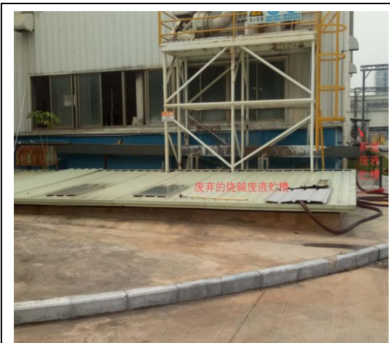
地下废液贮槽（新建 1 个+废弃 1 个）
