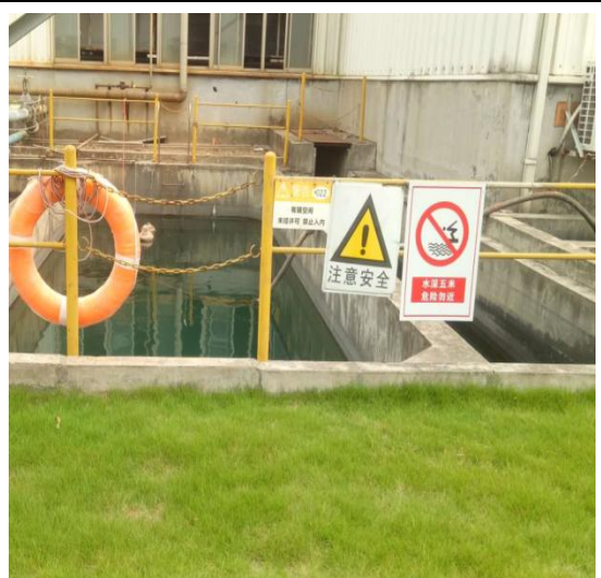
铸造车间外冷却水贮池
